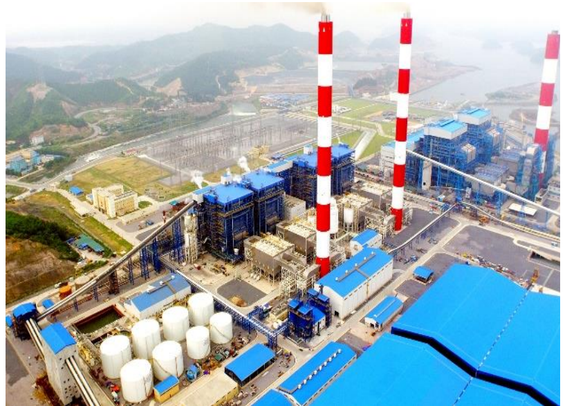
Hình 1. 1: Nhà máy nhiệt điện Mông Dương
