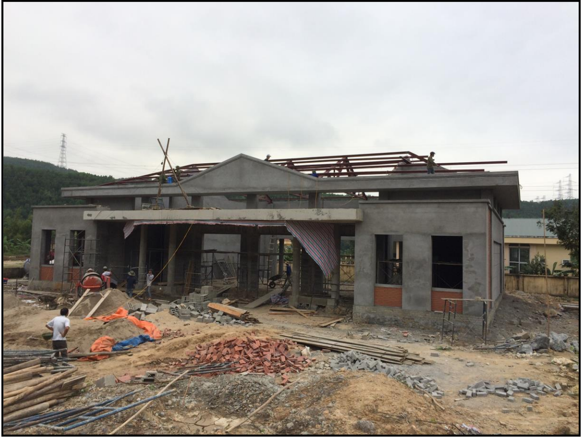
Hình 1.5. Nhà văn hóa trung tâm xã Dân Chủ - huyện Hoà Bình đang trong thời gian thi công
