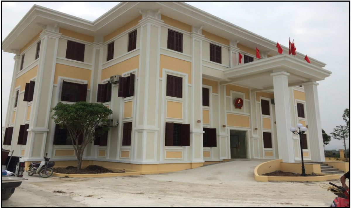
Hình 1.3. Viện kiểm soát nhân dân huyện Hoành Bò đã thi công xong, đưa vào khai thác sử dụng năm 2017
