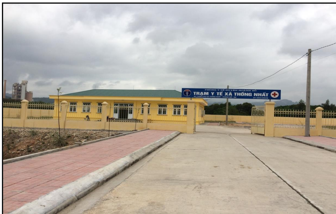
Hình 1.8. Trạm Y tế xã Thống Nhất, huyện Hoành Bồ, đưa vào khai thác sử dụng năm 2017
