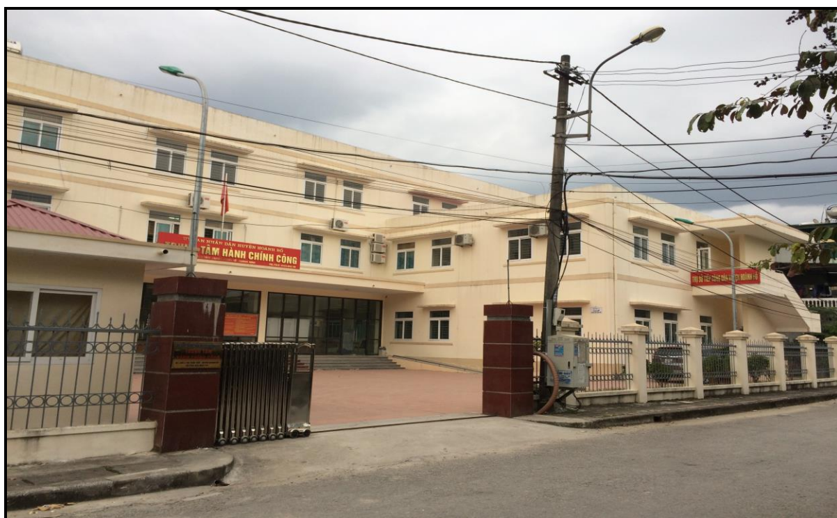
Hình 1.7. Trung tâm hành chính công, huyện Hoàn Bô đã đưa vào khai thác sử dụng năm 2016
