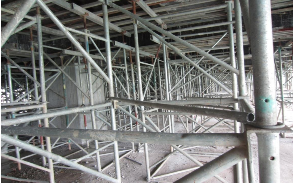
Hình 1.8: Công trình sử dụng gỗ dàn làm ván khuôn dầm, sàn tại dự án Star City
