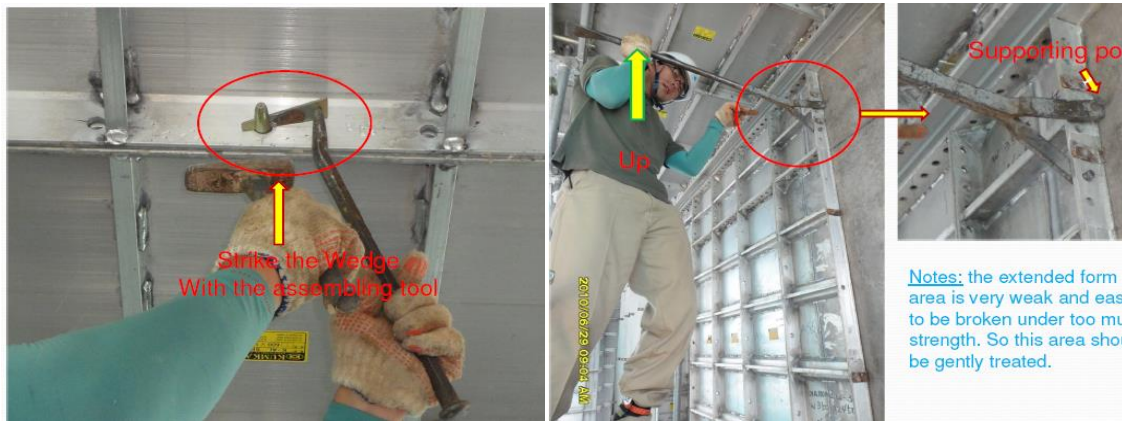
Hình 3.11: Hình ảnh tháo dỡ ván khuôn tường
