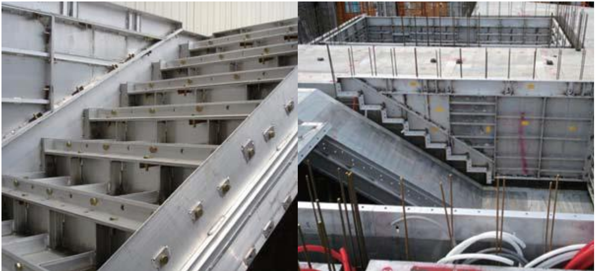
Hình 3.9: Hình ảnh ván khuôn thang bộ
