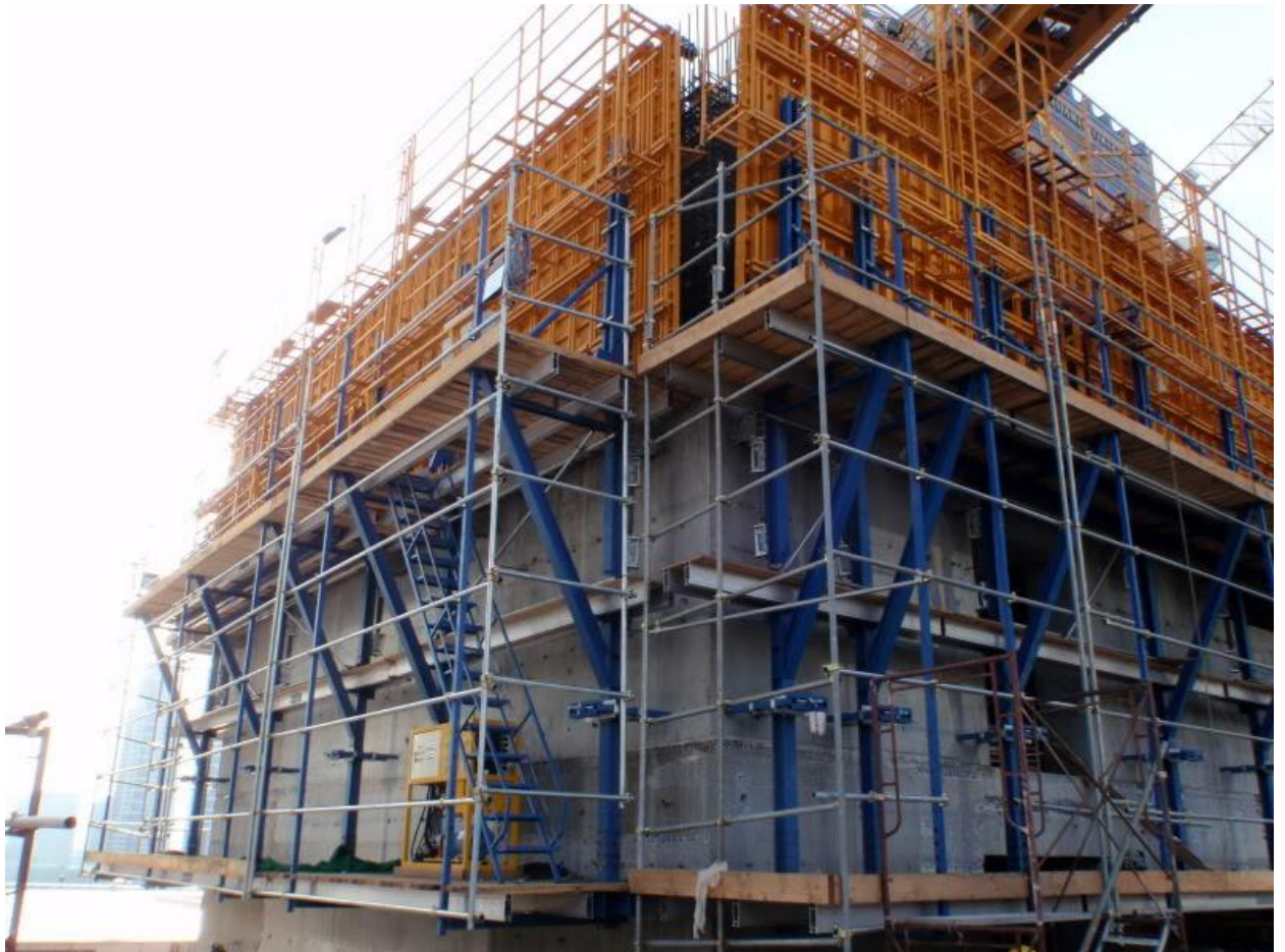
Hình 1.1: Hình ảnh ván khuôn trượt
