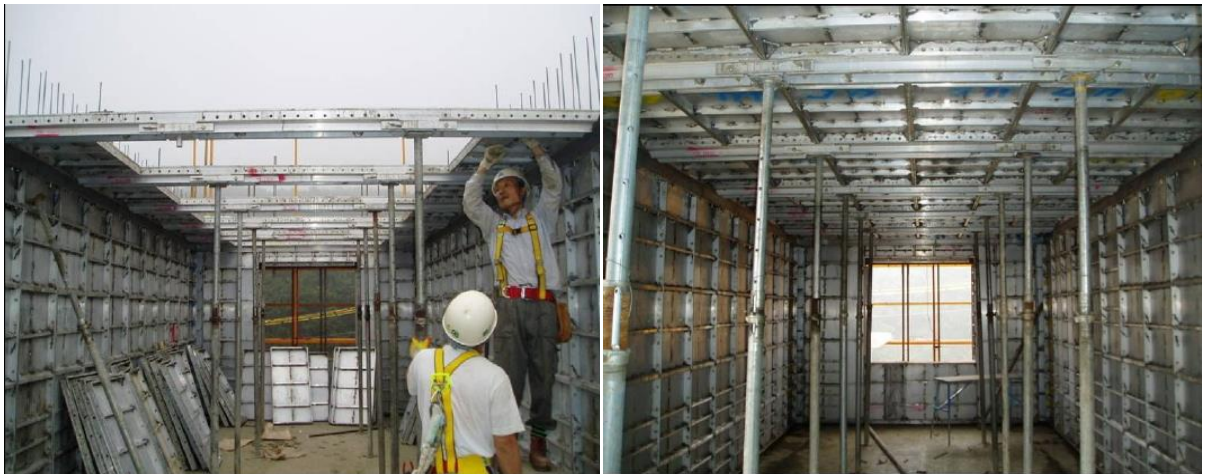
Hình 3.10: Hình ảnh thi công ván khuôn dầm sàn
