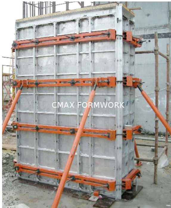
Hình 3.3: Hình ảnh thực tế thi công ván khuôn cột
