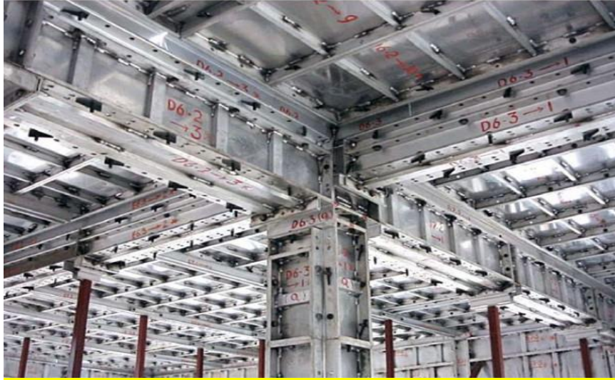
Hình 1.7: Hình ảnh thi công ván khuôn nhôm tại dự án Hyundai Hill State
