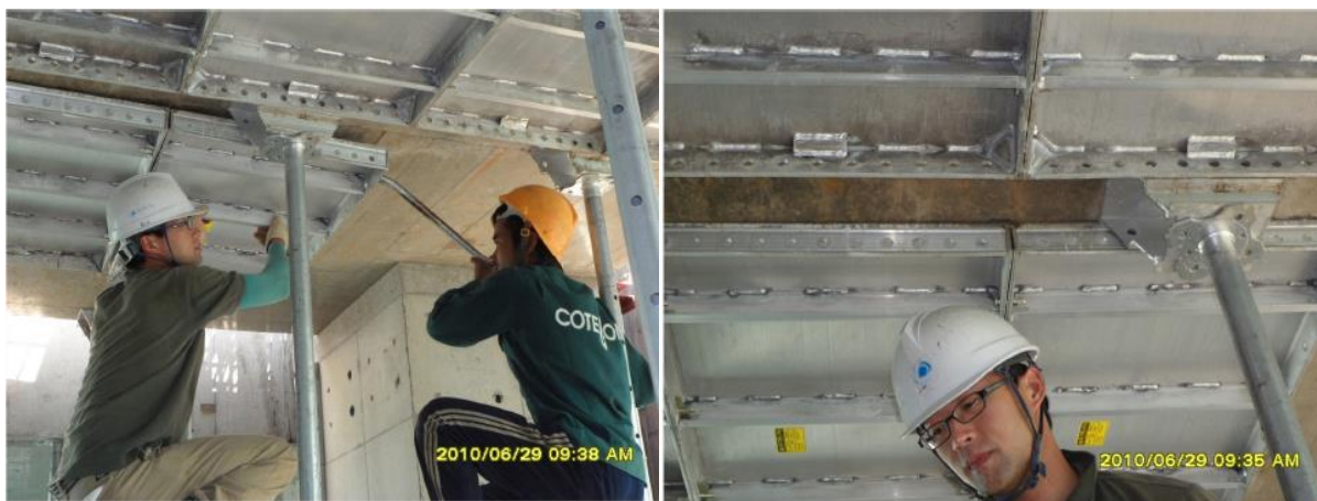
Hình 3.12: Hình ảnh tháo dỡ ván khuôn dầm, sàn
