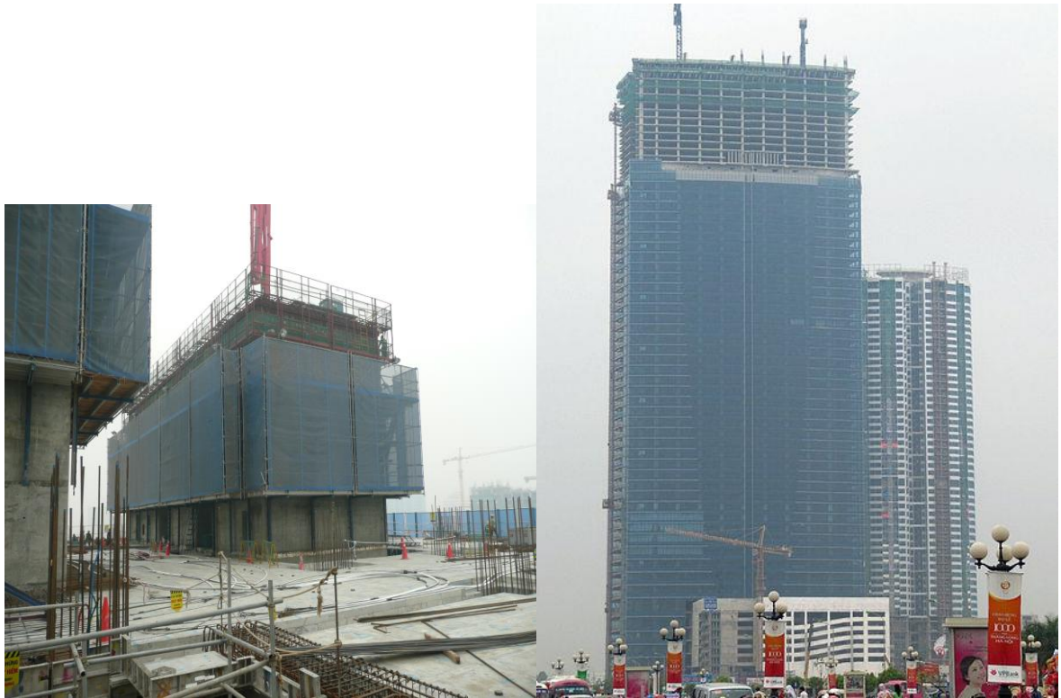
Hình 1.6. Cần phân phối bê tông tại dự án Keangnam Landmark Tower
