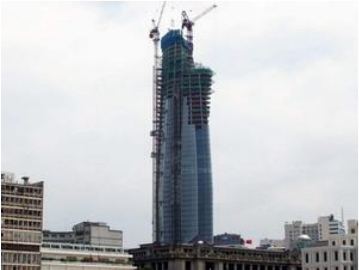
Hình 1.7. Thi công bơm bơm bê tông tầng 65 tòa nhà Bitexco
