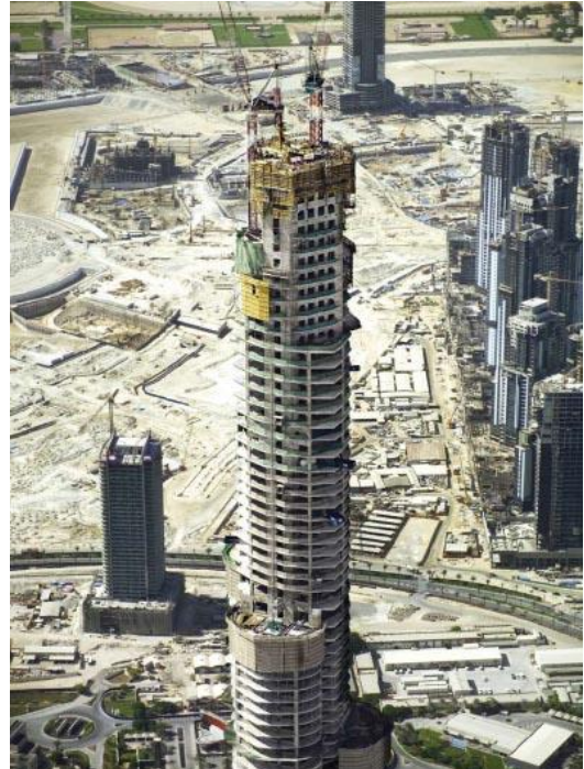
Hình 1.5. Bơm bê tông liên tục lên đến độ cao 601m tại dự án Burj Dubai
