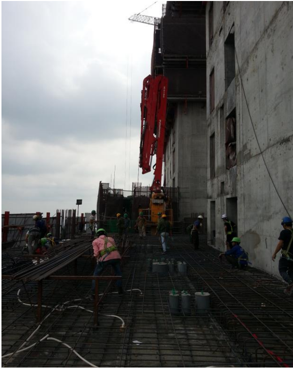
Hình 1.8. Cẩu phân phối bê tông thi công tầng 61 công trình Lotte Center Hanoi.
