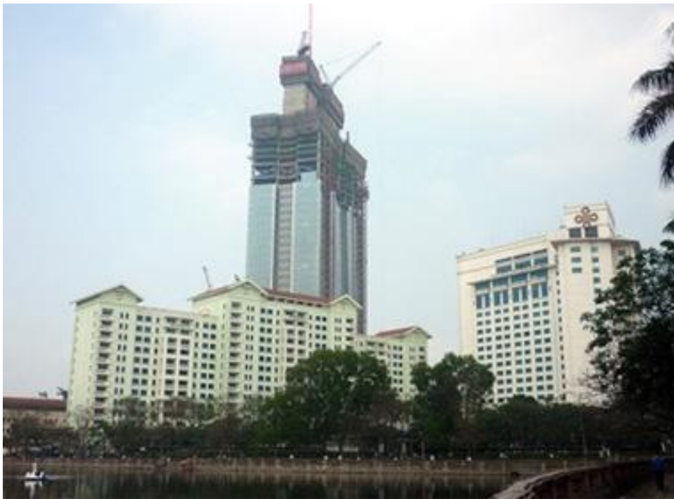
Hình 1.9. Bơm bê tông tầng 65 tại dự án Lotte Center
