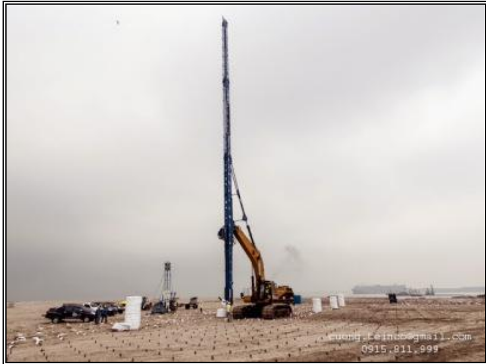
Hình 2.10: Thi công ép bấc thấm
