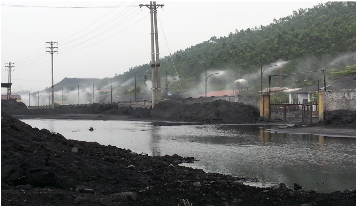
Hệ thống phun sương chống bụi nhà sàng +56
