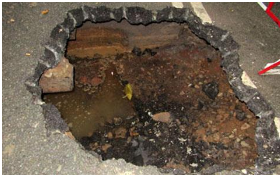
H2.9 Kết cấu áo đường bị lún sụp thành hố sâu tại vị trí cống ngầm
