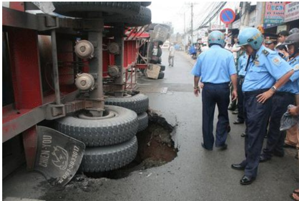
H2.8 Sụp kết cấu áo đường trên đường ống thoát nước dọc đường
