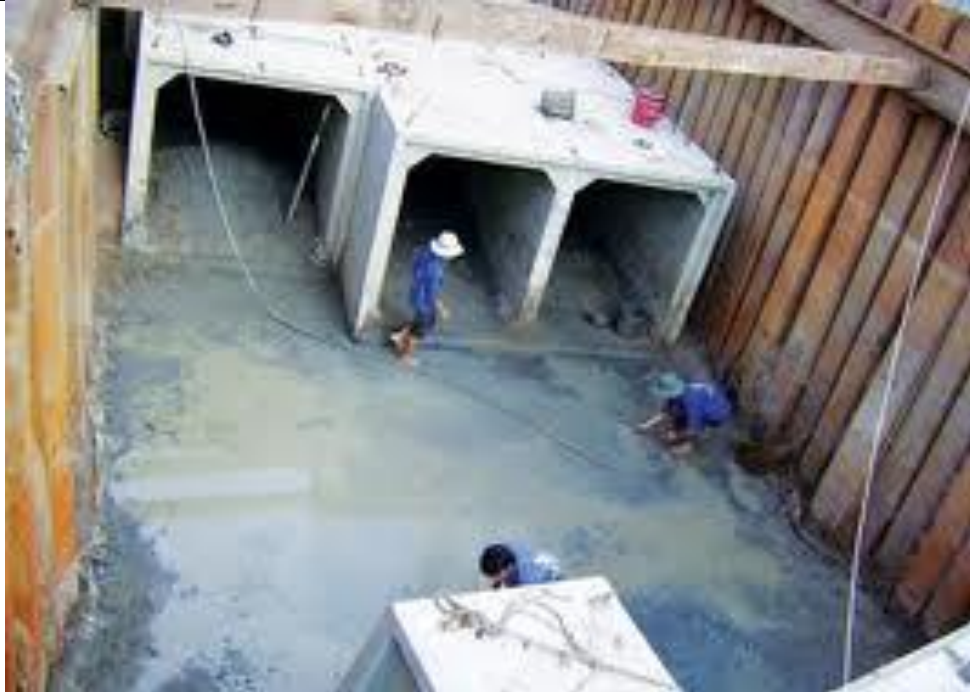
H3.8. Dùng cọc cừ ván thép giữ ổn định mái đào thi công đường ống cấp thoát nước
