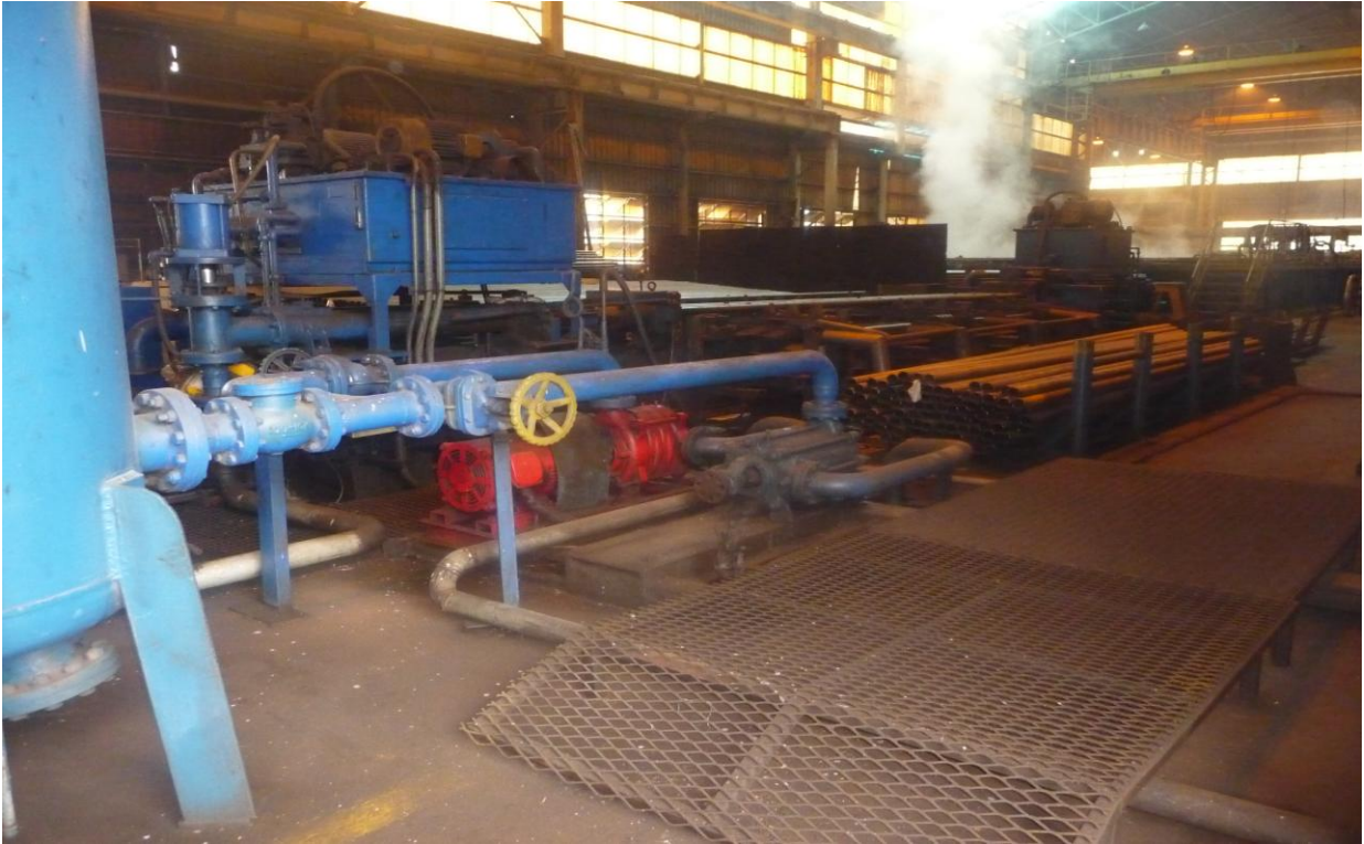
Hình 2.37. Công đoạn thử áp lực.
